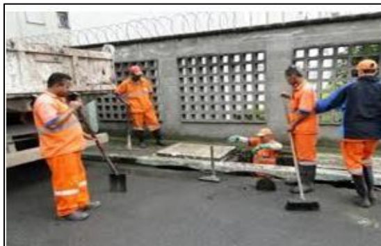
Limpeza de Boca de Lobo
