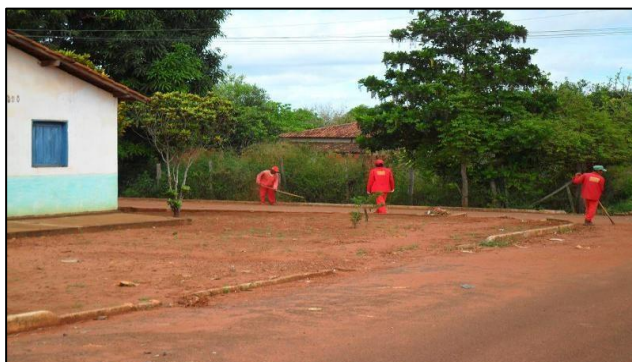
Manutenção das Vias Públicas
