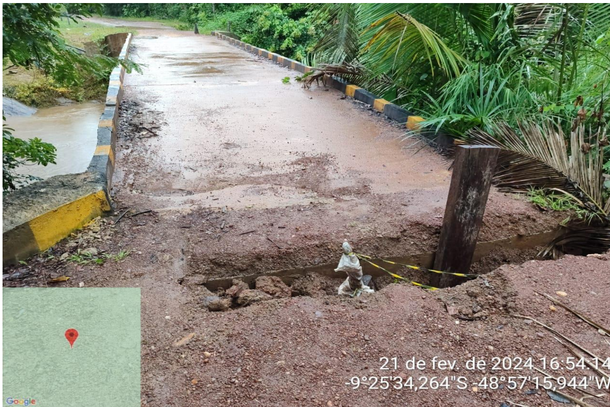
FIGURA 1: PONTE SOBRE O RIO LAJEADO, REGIÃO DO SR. EUPÍDIO.
