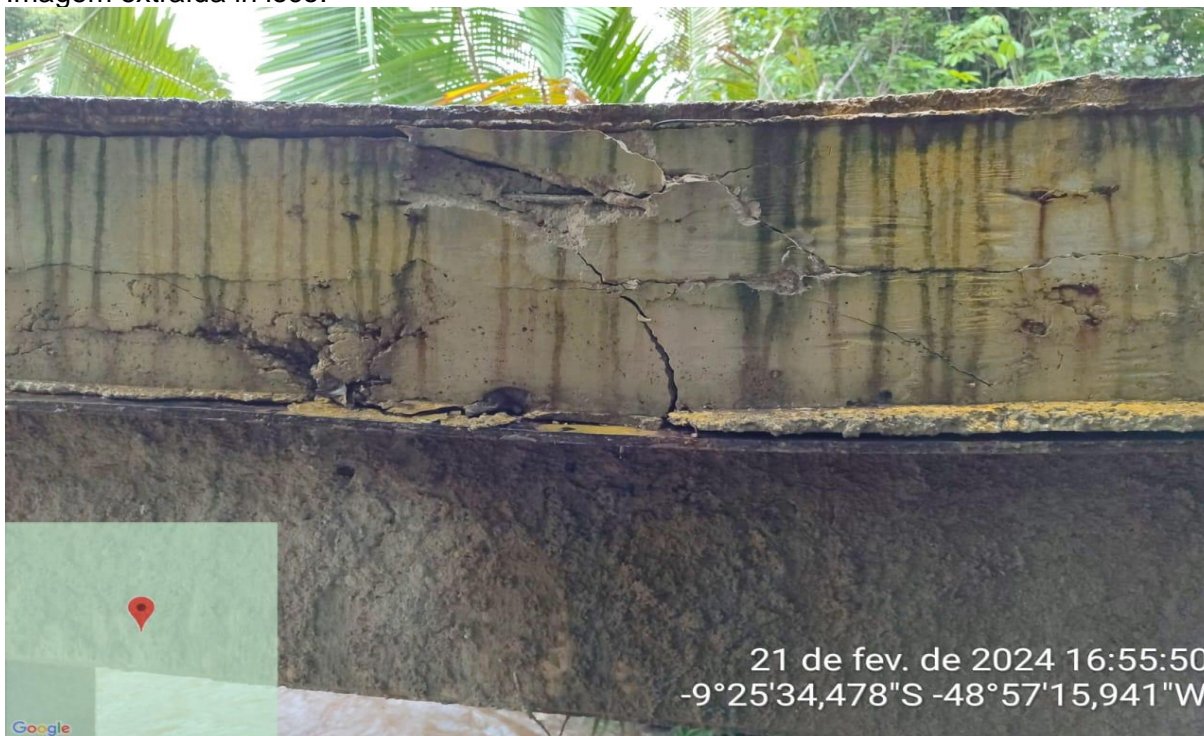
FIGURA 2: PONTE SOBRE O RIO LAJEADO, REGIÃO DO SR. EUPÍDIO.
